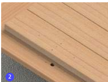
2 PRE-FORATURA ESEGUITA PRE-DRILLING DONE
